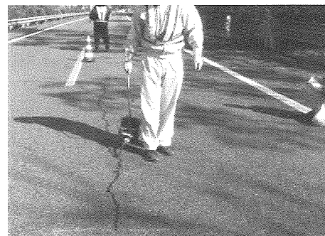
写真-4 浸透型クラックシール材注入
