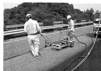
写真-12 試作注入機
