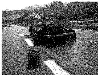
写真-7 敷幅3.5mのディストリビュータ
