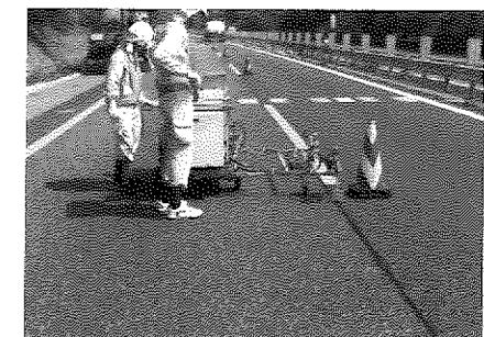
写真-5 舗装縦継目への注入
