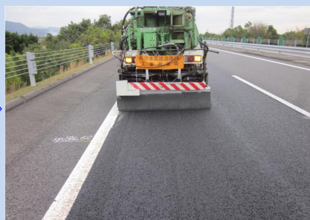
分解剤散布 (標準散布量0.5 ℓ / m 2 )
