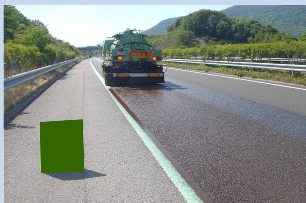
浸透型補修材散布 (標準散布量2.1 ℓ / m 2 )
