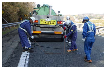
写真-5 クラックシール状況
