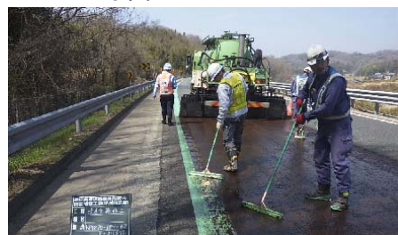
写真-8 散布工
