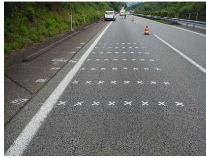
写真-3 散布区間 32 か月後
