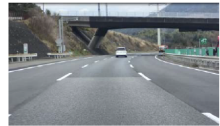
写真-5 散布区間 41 か月後
