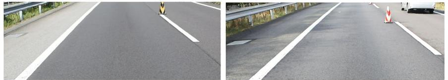
写真-1 骨材飛散の少ない現場の路面状況 (左：散布前，右：散布後 7 ヶ月)
