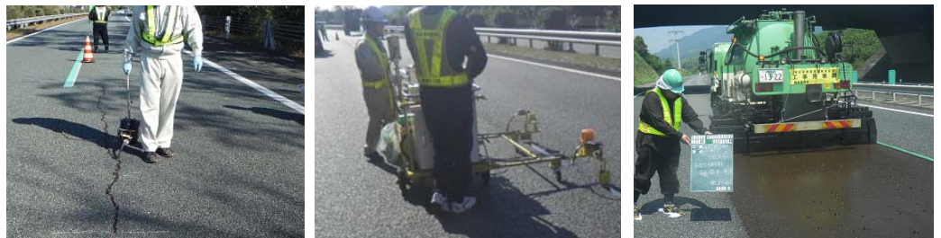
写真-1 浸透型クラックシール材 写真-2 浸透型補修材注工 写真-3 浸透型補修材散布工
