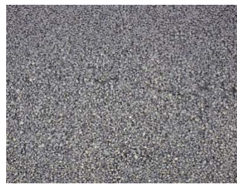
写真-3 施工直後
