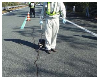
写真-1 浸透型クラックシール材注入状況 写真-2 浸透型補修材散布工施工状況
