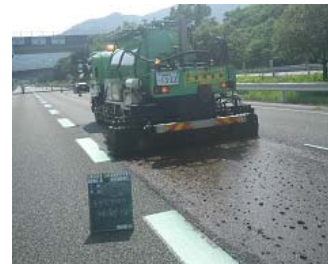
写真-1 浸透型クラックシール材注入状況 写真-2 浸透型補修材散布工施工状況
