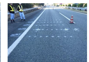
写真-6 未施工工区の1年後
