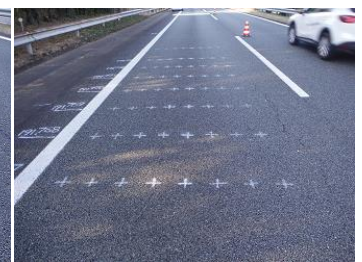
写真-4 未施工工区の1ヵ月後
