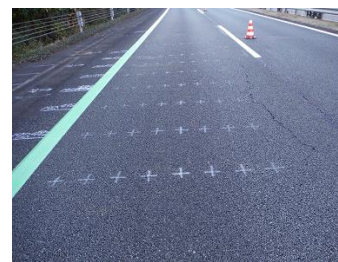
写真-3 施工工区施工1ヵ月後
