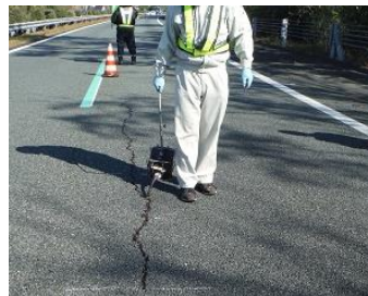
写真-1 浸透型クラックシール材注入状況
