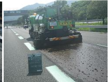
写真-2 浸透型補修材散布工施工状況
