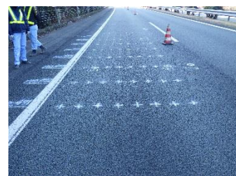
写真-5 施工工区施工1年後
