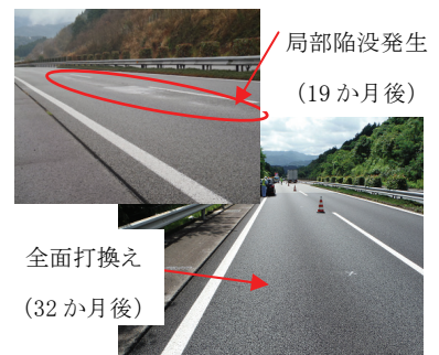
写真-7 散布 19 ヶ月後および 32 ヶ月後（無散布工区）
