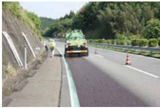
写真-1 浸透型補修材散布
