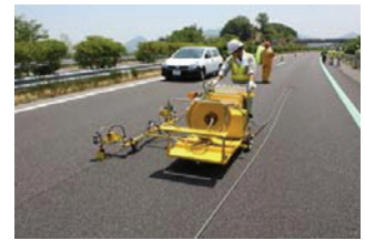
写真-5 舗装縦継目への浸透型補修材注入
