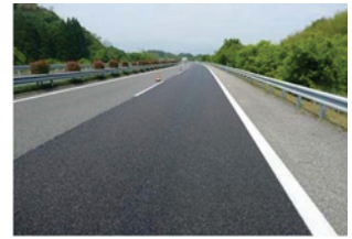
写真-4 施工完了
